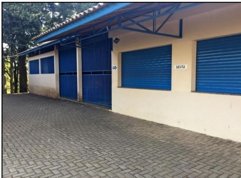
FOTOGRAFIA 16 – COZINHA INDUSTRIAL HEND EL ACHKAR
