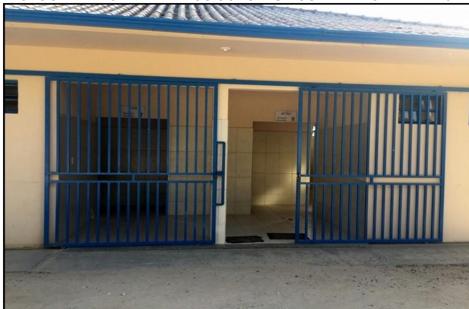
FOTOGRAFIA 10 – BANHEIROS CONSTRUÍDOS NA REFORMA DE 2012
